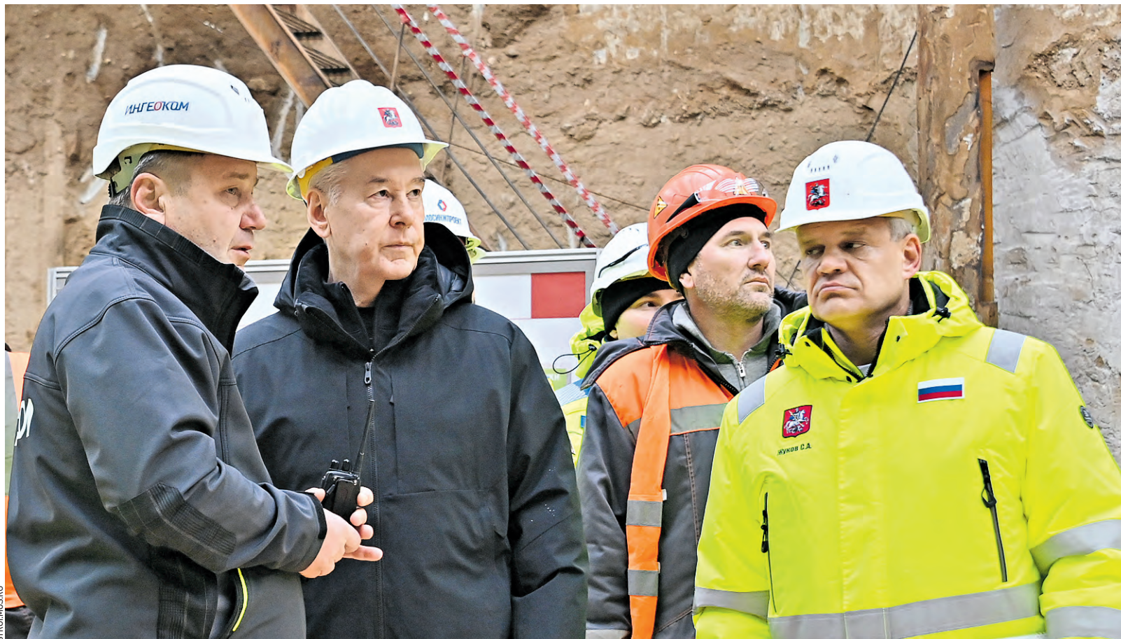
25 ноября 2024 года. Мэр Москвы Сергей Собянин (в центре), председатель правления АО «Объединение «ИНГЕОКОМ» Дмитрий Евсеев (слева) и первый замгендиректора АО «Мосинжпроект» Сергей Жуков на выходе щита при строительстве станции «Бульвар Генерала Карбышева»
