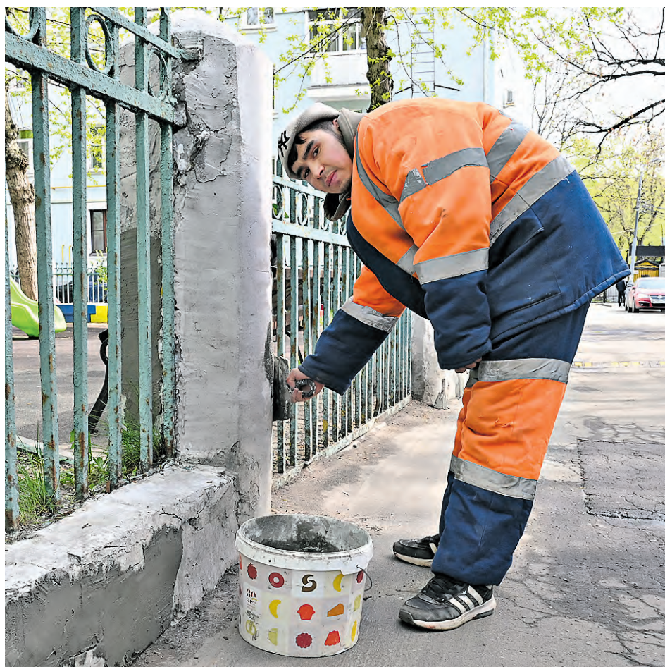
21 апреля. Сотрудник ГБУ «Жилищник района Южнопортовый» штукатур Асламбек Акбаров восстанавливает покрытие опор забора на улице Трофимова. ФОТО: АНАТОЛИЙ ЦЫМБАЛЮК
