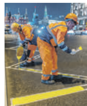
7 августа 2016 года. Нанесение дорожной разметки на Тверской улице
