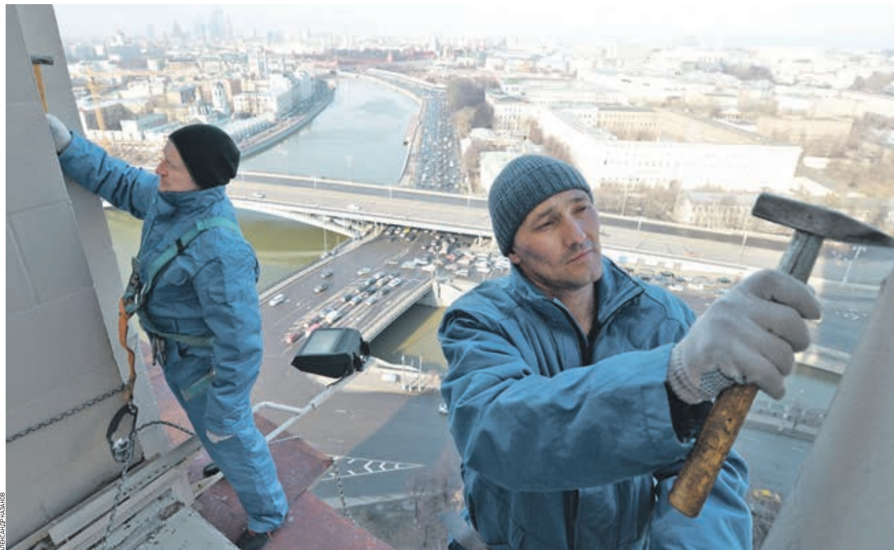
13 марта 2015 года 12:19 Промышленные альпинисты Владимир Королев (справа) и Дмитрий Столяров (слева) проверяют плитку на фасаде высотки на Котельнической набережной. Чтобы выявить плохо закрепленные фрагменты облицовки, мастера аккуратно простукивают камень молотками. Плитку с дефектами оперативно заменяют новой
