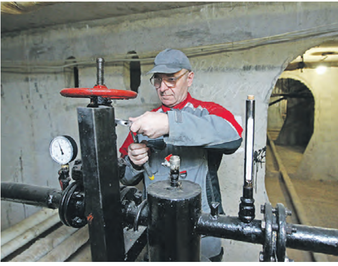
5 июня 12:45 Мастер на все руки Леонид Ярмолук в подвале дома на ул. Цюрупы, 8, проверяет готовность системы отопления к новому сезону
