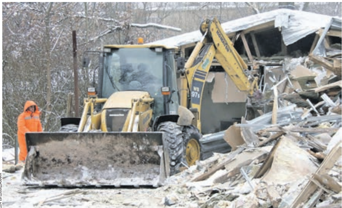
Вчера 10:37 Парк культуры и отдыха «Фили». Рабочие с помощью техники демонтируют самострой. С наступлением тепла территория, ранее занимаемая павильонами, будет благоустроена и станет доступна для посетителей парка
