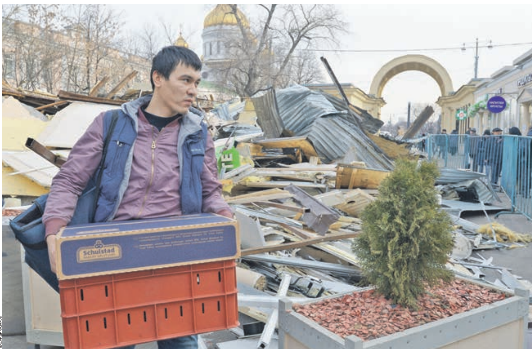
Вчера 13:46 Станция метро «Кропотинская». Здесь на месте ларьков осталась только груда металлопрофиля. Уже спустя пару дней строительный мусор будет убран, а территория, где раньше находились незаконные торговые объекты, — благоустроена
