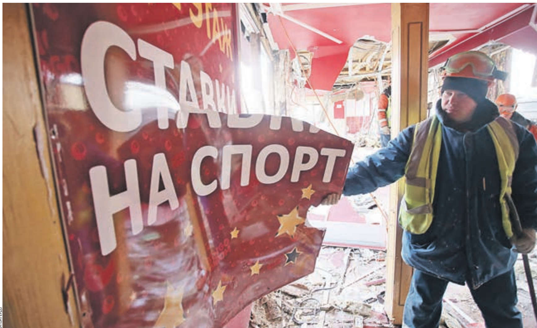
Вчера 14:15 Станция метро «Алексеевская». Рабочий одной из бригад ГБУ «Гормост» Сергей Недяров принимает участие в сносе незаконных торговых павильонов...
