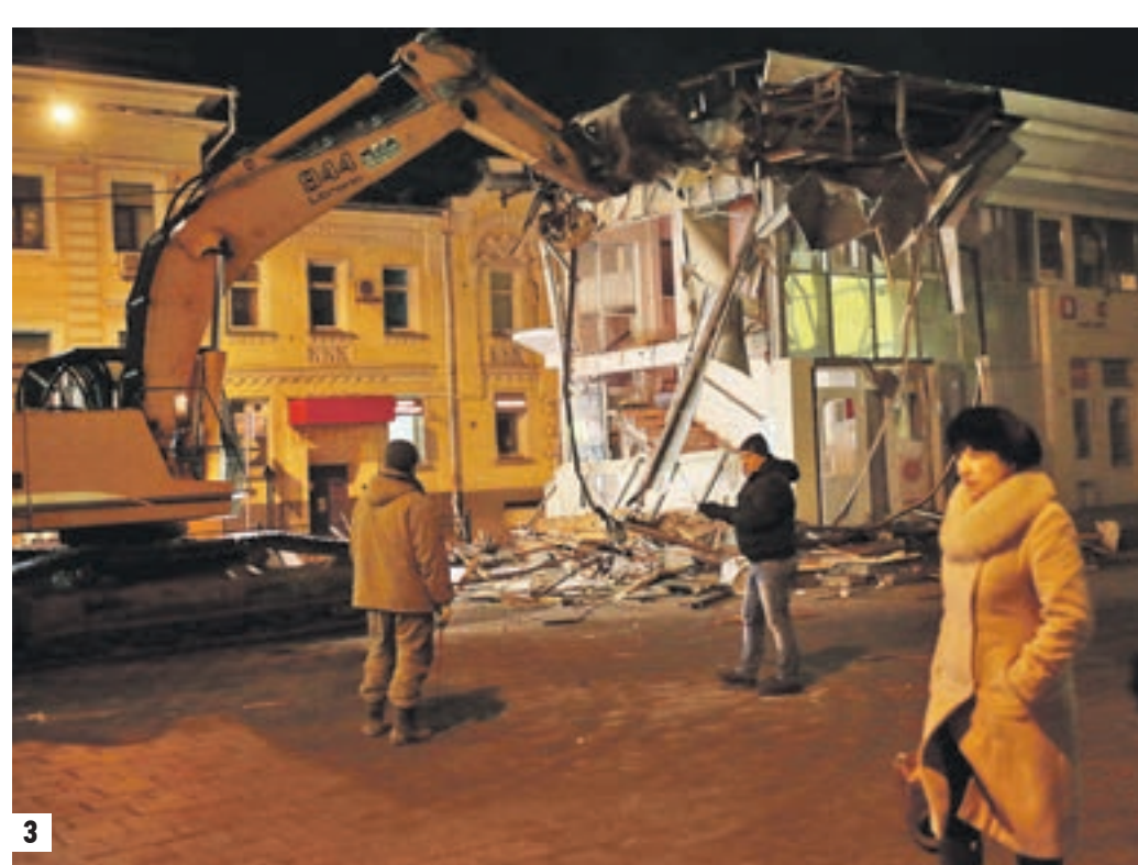
Вчера 00:25 Станция метро «Сухаревская». Полиция убеждает протестующих не мешать экскаватору работать (1) Вчера 14:10 Бригада ГБУ «Горимст» сносит нелегальные постройки над пешеходным переходом у станции метро «Алексеевская» (2) Вчера 02:14 Демонтаж павильонов у станции метро «Чистые пруды» (3)
