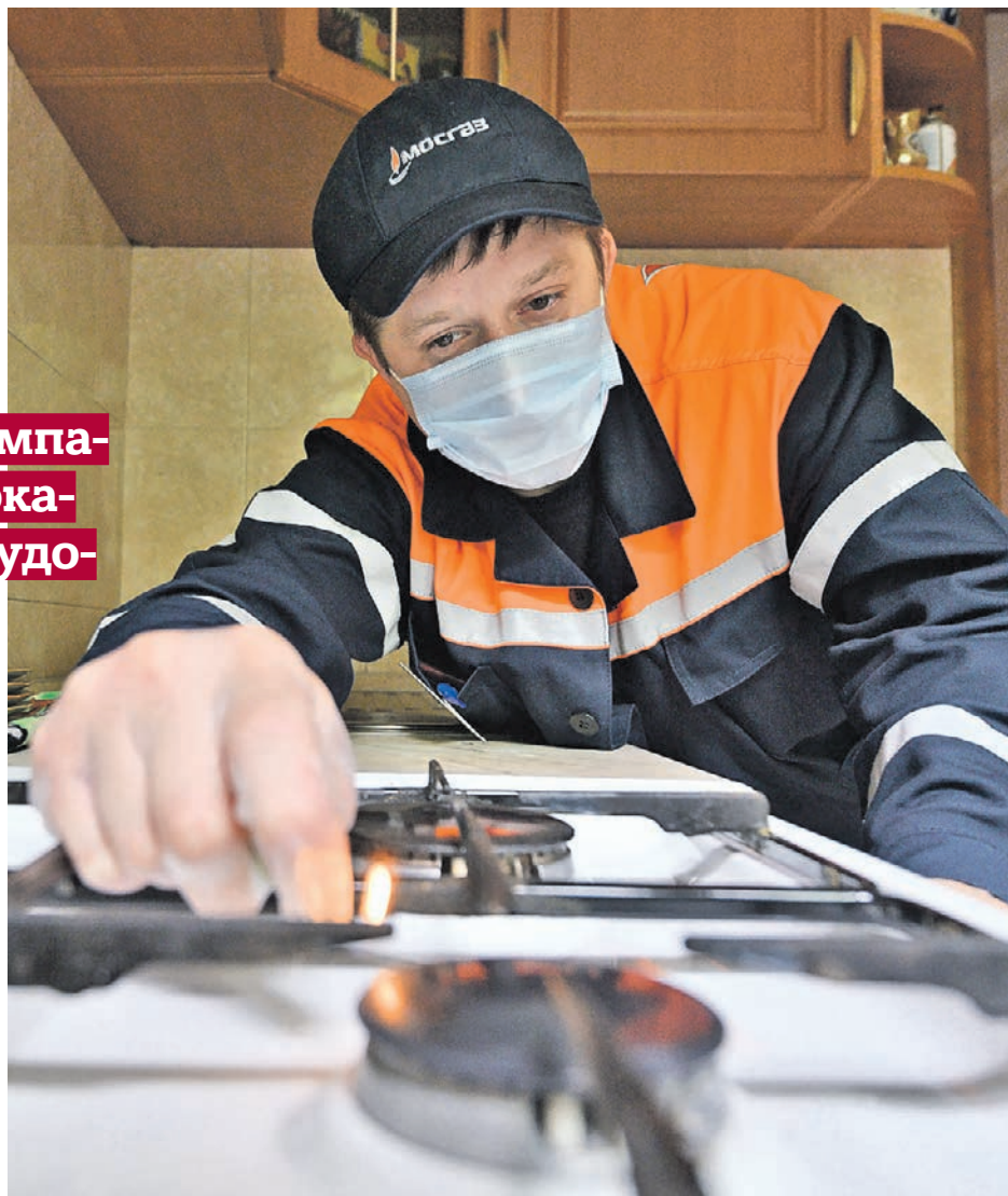
8 июля 2020 года. Слесарь Мосгаза Михаил Бульчев проводит плановое обслуживание газового оборудования в квартире на Сиреневом бульваре
