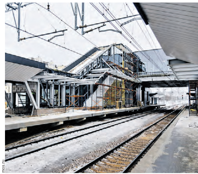
Строительство станции Очаково, которая войдет в состав четвертого Московского центрального диаметра
