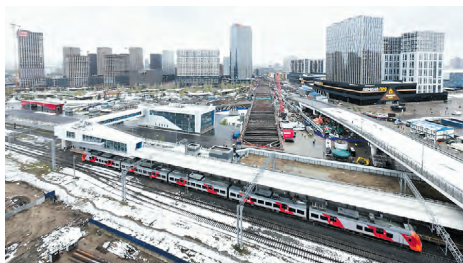
Территория строящейся станции Бирюлевской линии московского метро
