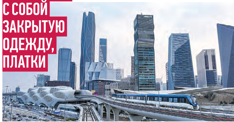
Вид на одну из станций метро в столице Саудовской Аравии Эр-Рияде и деловой район рядом с ней
