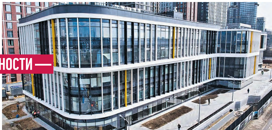
Новый корпус знаменитой Курчатовской школы в районе Покровское-Стрешнево, который откроет свои двери уже в сентябре этого года
