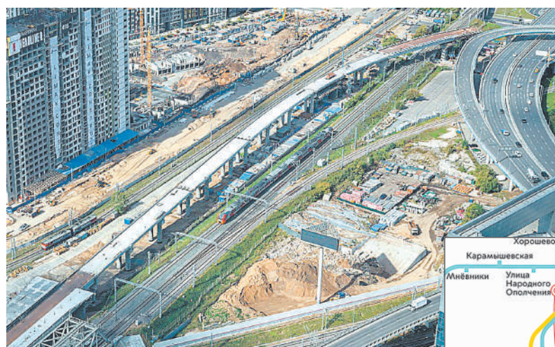
Строительство линии D4 и ж/д станции Камушки.
