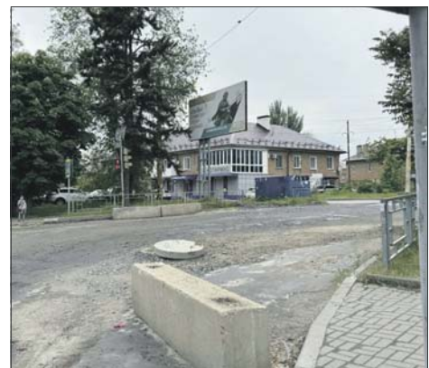
Участок дороги ремонтируют более года.
