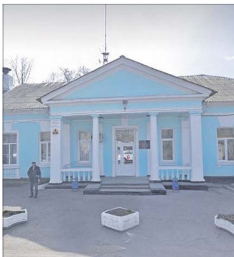
Ремонт планировался в двух зданиях ВГСЧ.
