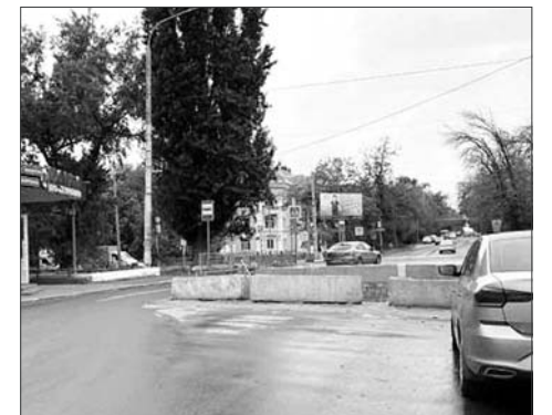
Ремонт дорожного полотна на улице Садовой превратился в очередной долгострой.
