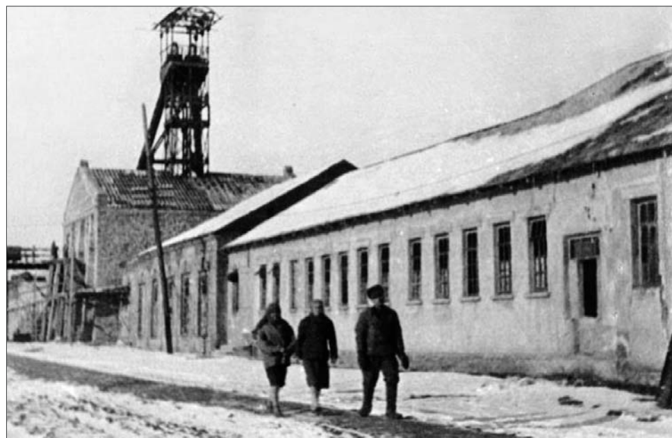
Фотография шахты имени Октябрьской Революции: на переднем плане — баня и «грязная» раздевалка, далее — здание ламповой и отметки, на заднем плане — надшахтное здание и копер клетового людского ствола.
