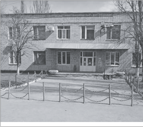
Ремонтные работы в здании на Минском завершены, осталось решить вопрос оснащения его мебелью и необходимым оборудованием.
