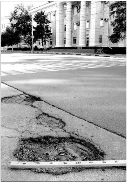
Волонтер измеряет параметры ям и передает данные в ГИБДД.
