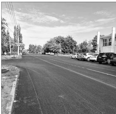
Дорогу ремонтировали с марта 2025 года.
