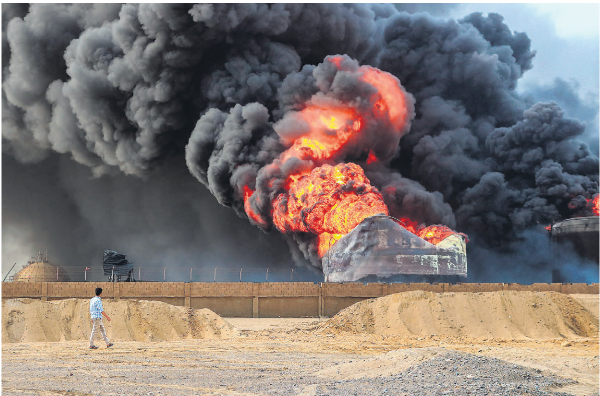
Под израильский обстрел города Ходейда попали, в частности, электростанция и нефтехранилище, в результате чего возник сильнейший пожар ФОТО AFP
