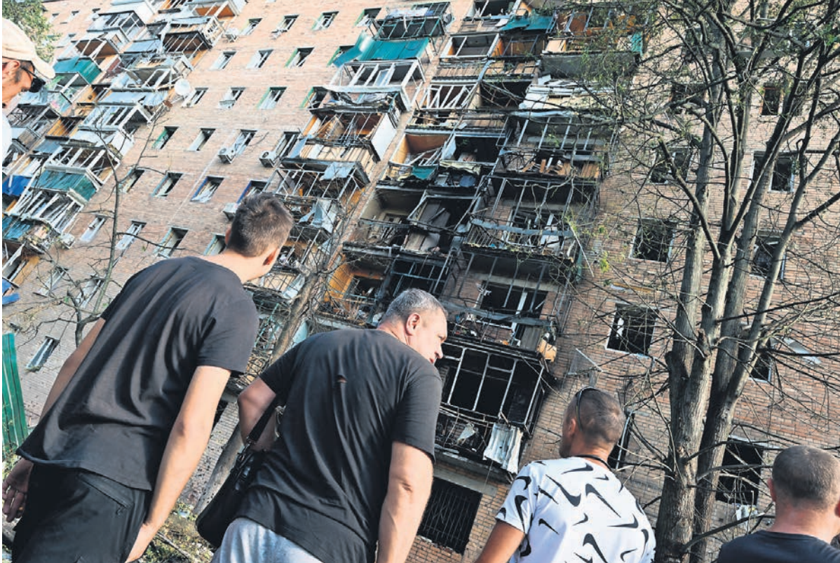
Глядя на поврежденный дом, часть его жителей планирует эвакуироваться, а часть — остаться и записаться в ополчение ФОТО АНАТОЛИЯ ЖДАНОВА
