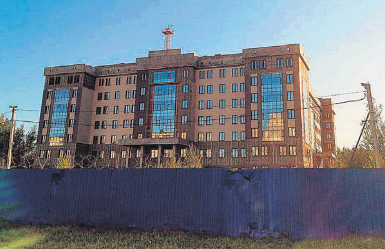
Здание ярославской полиции, при строительстве которого было похищено около 300 млн руб., пока так и не принято в эксплуатацию ФОТО АНТОНА ГОЛИЦЫНА
