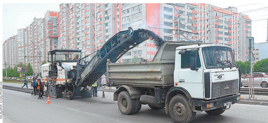
Ремонт дороги на ул. Попова обойдется в 112 млн рублей.
