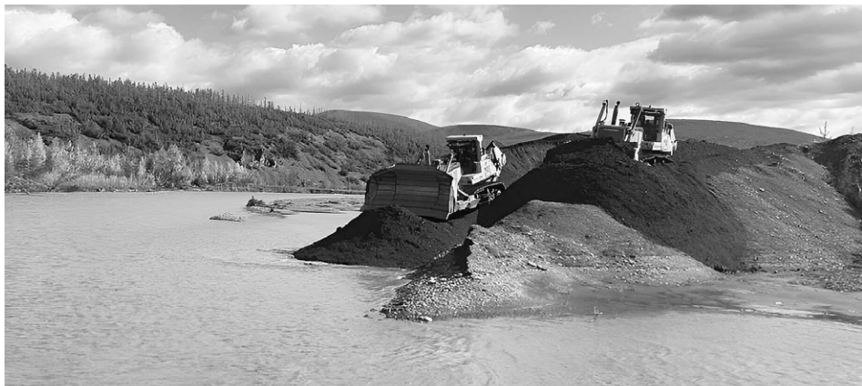
На участках трассы постоянно идут ремонтные работы.
