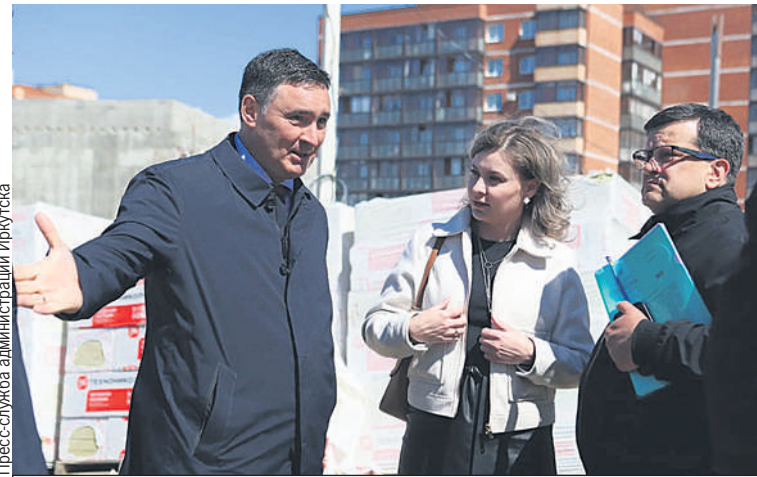
Мэр Иркутска и представители областного правительства проверили, как идут работы на стройплощадке.
