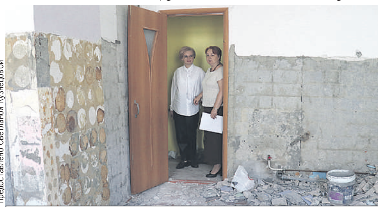
Проверка ремонта в детском учреждении.
