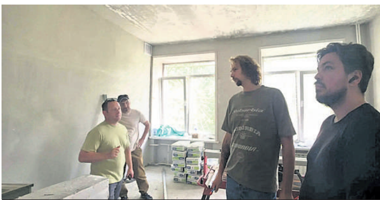
В третьей по счету «ТОЧКЕ» идут ремонтные работы.
