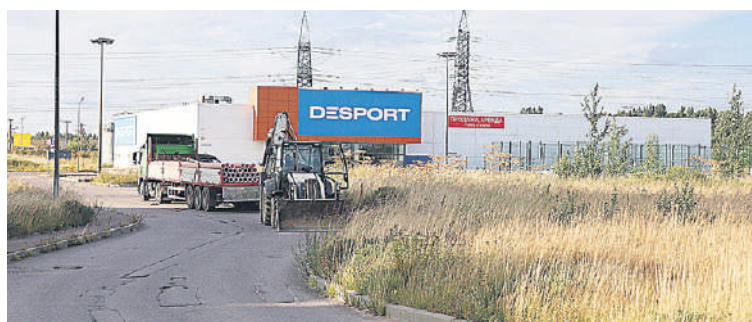
Прокладка электрических кабелей к жилой застройке «Еврограда».
