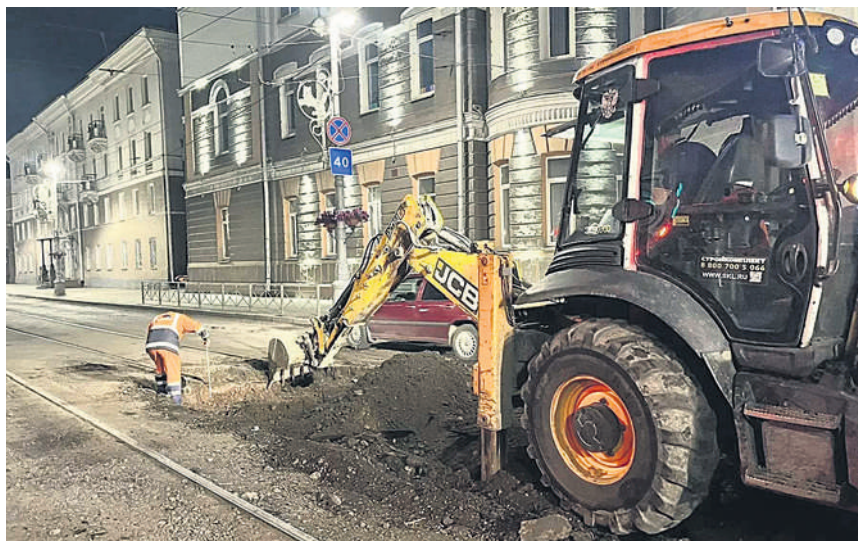
При проведении работ стараются не мешать движению на центральной улице.
