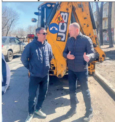
Ремонт ул. Розы Люксембург.
