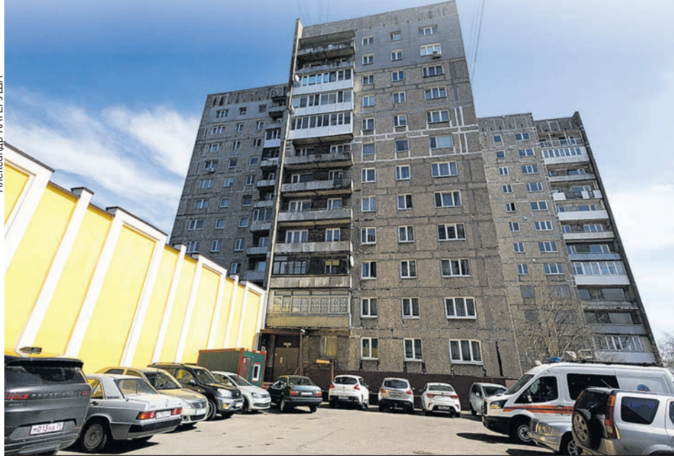
Здания соединены балконами, поэтому есть серьезный риск, что аварийное потянет за собой другое.
