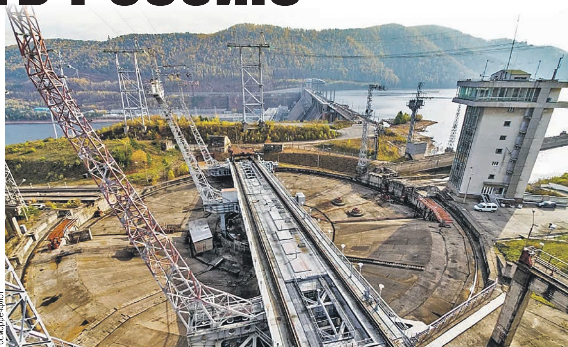
Поворотное устройство Красноярского судоподъемника.
