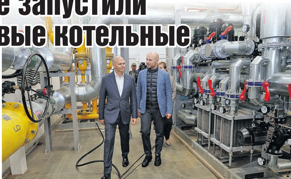
Алексей Беспрозванных осматривает современные теплопункты.
