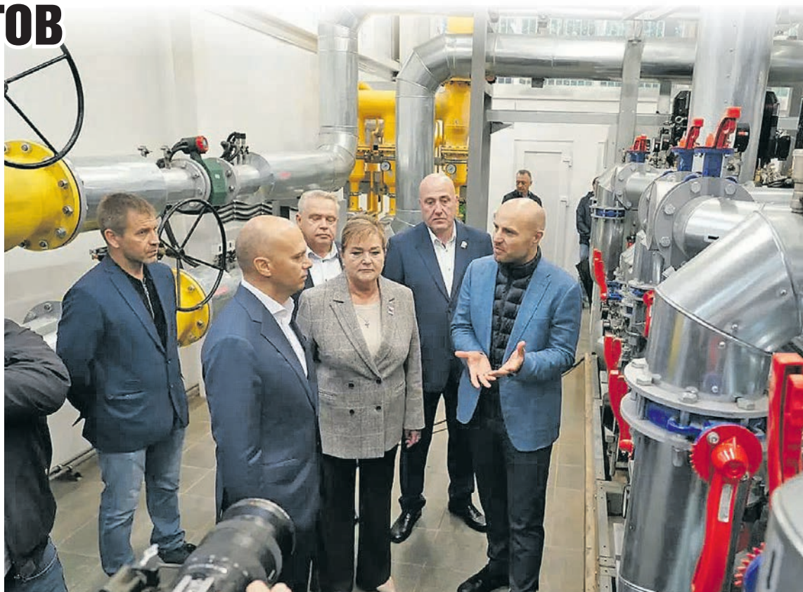
Алексей Беспрозванных недавно принял участие в запуске новых газовых котельных в Балтийске. В регионе сделана большая подготовительная работа к холодному периоду.
