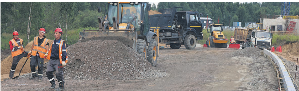
Дороги строят одновременно с жильем.
