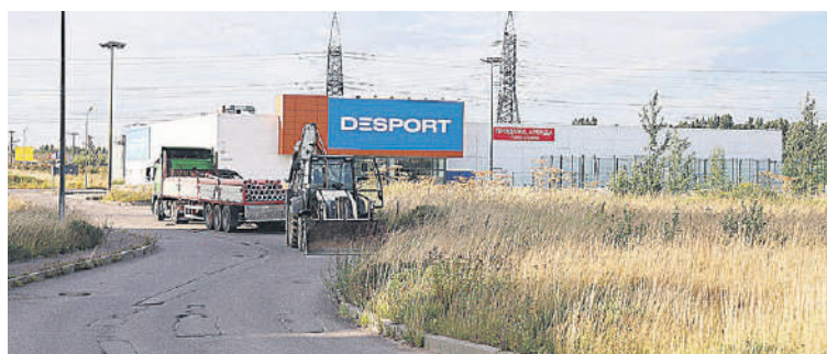
Прокладка электрических кабелей к жилой застройке «Еврограда».
