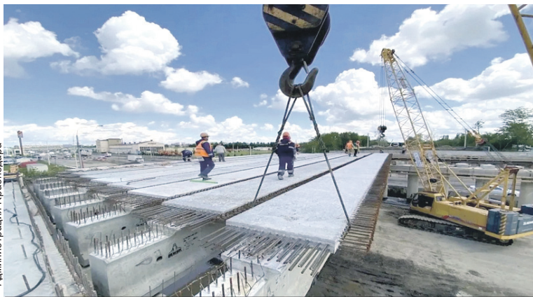
Реконструкция Фадеевского путепровода находится в активной фазе.
