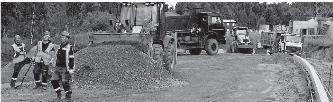
Дороги строят одновременно с жильем.
