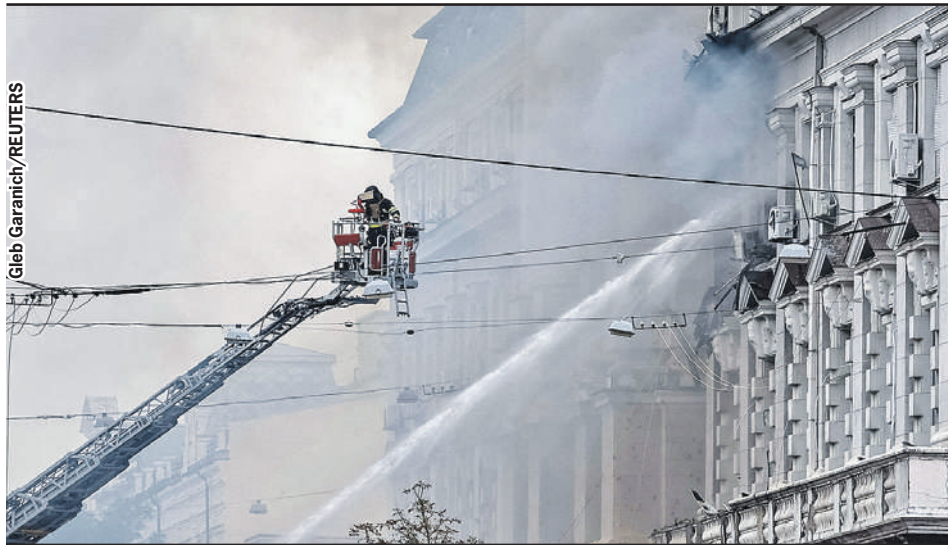
Здание Службы безопасности Украины (СБУ) в центре Киева после удара беспилотника. 4 сентября 2026 г.
