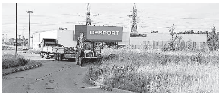
Прокладка электрических кабелей к жилой застройке «Еврограда».
