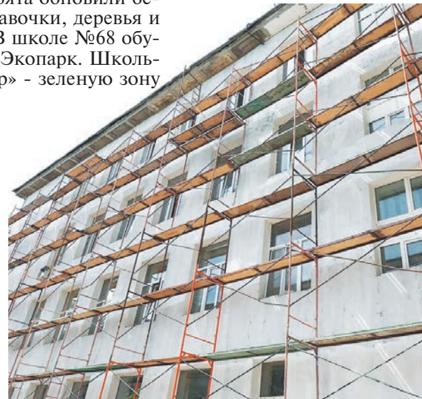
Школа №70 получила полноценный капитальный ремонт.
