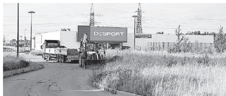
Прокладка электрических кабелей к жилой застройке «Еврограда».
