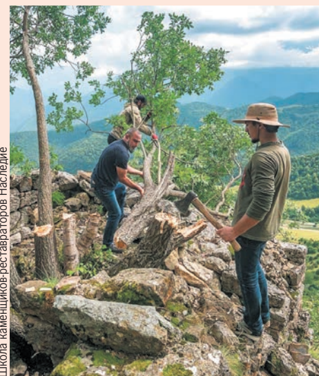
Школа каменщиков-реставраторов «Наследие»
