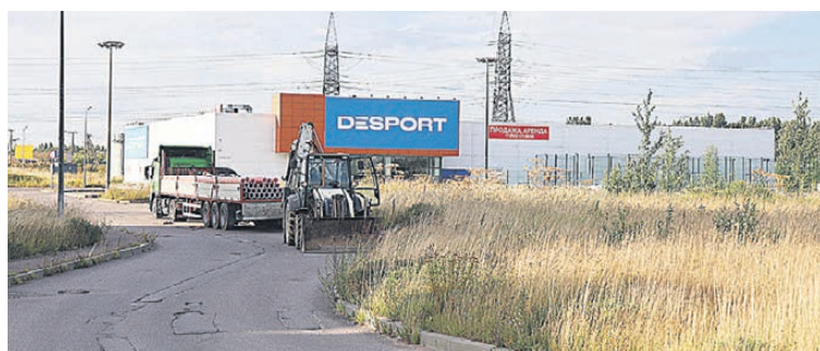
Прокладка электрических кабелей к жилой застройке «Еврограда».
