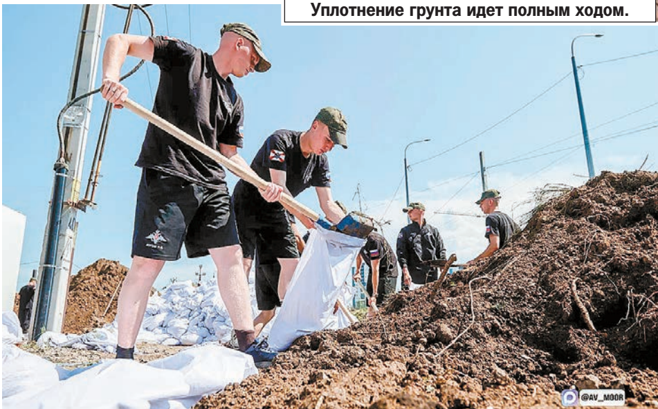
В Тюмени укрепляют насыпи.
