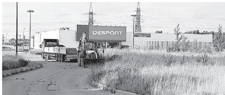
Прокладка электрических кабелей к жилой застройке «Еврограда».
