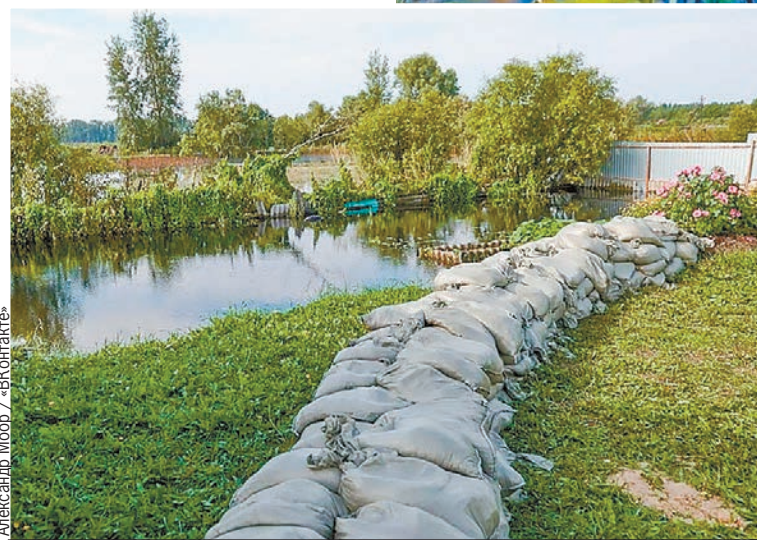
Волонтеры укрепляют насыпи.
