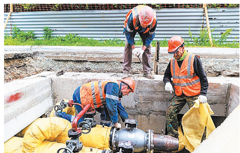
К централизованному отоплению подключены 1193 объекта.
