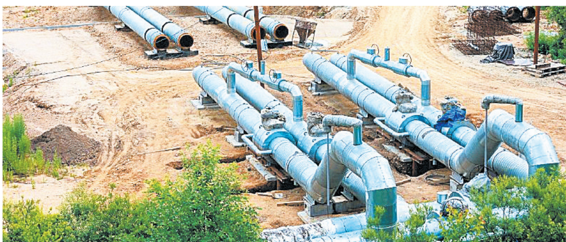
Артемовскому району будут переданы на баланс новые магистральные тепловые сети.
