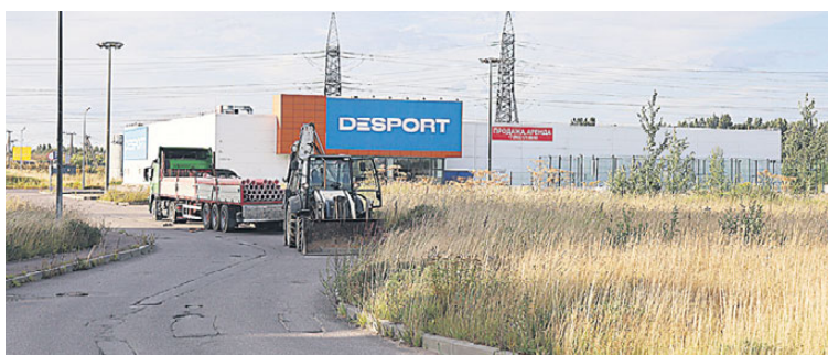
Прокладка электрических кабелей к жилой застройке «Еврограда».
