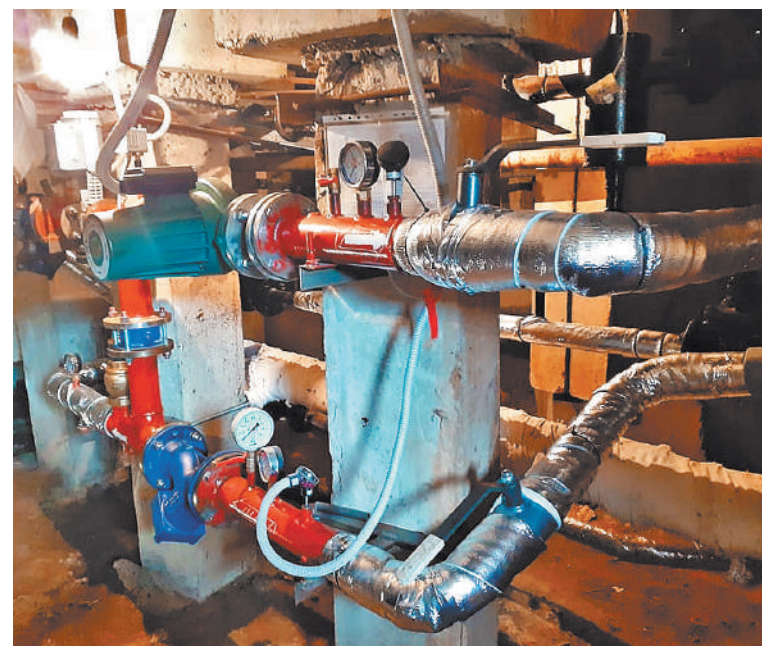
Так выглядит система теплоснабжения в одном из домов Барнаула после капремонта.
