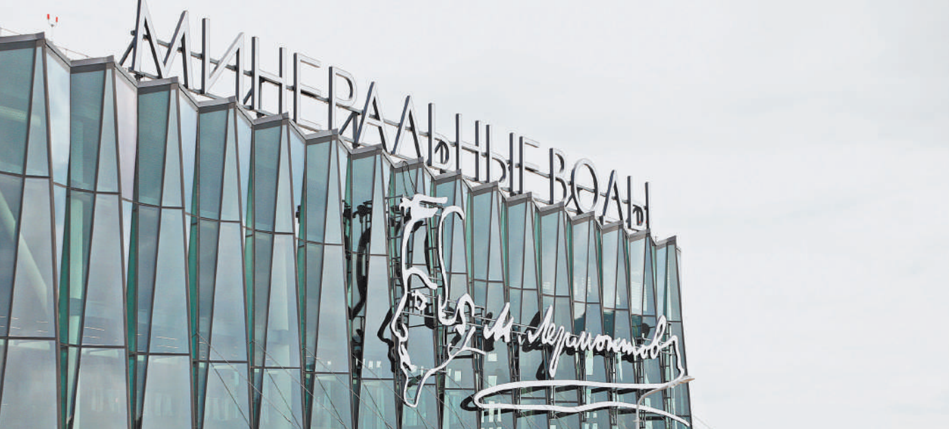
Терминал буквально просвечивает насквозь, его основа — стекло с легким голубоватым отливом, которое держится на мощной металлической конструкции.
