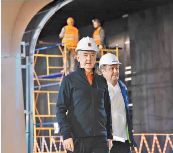
Сергей Собянин осматривает строительство станции «Народное Ополчение». Она готова на 60 процентов.
